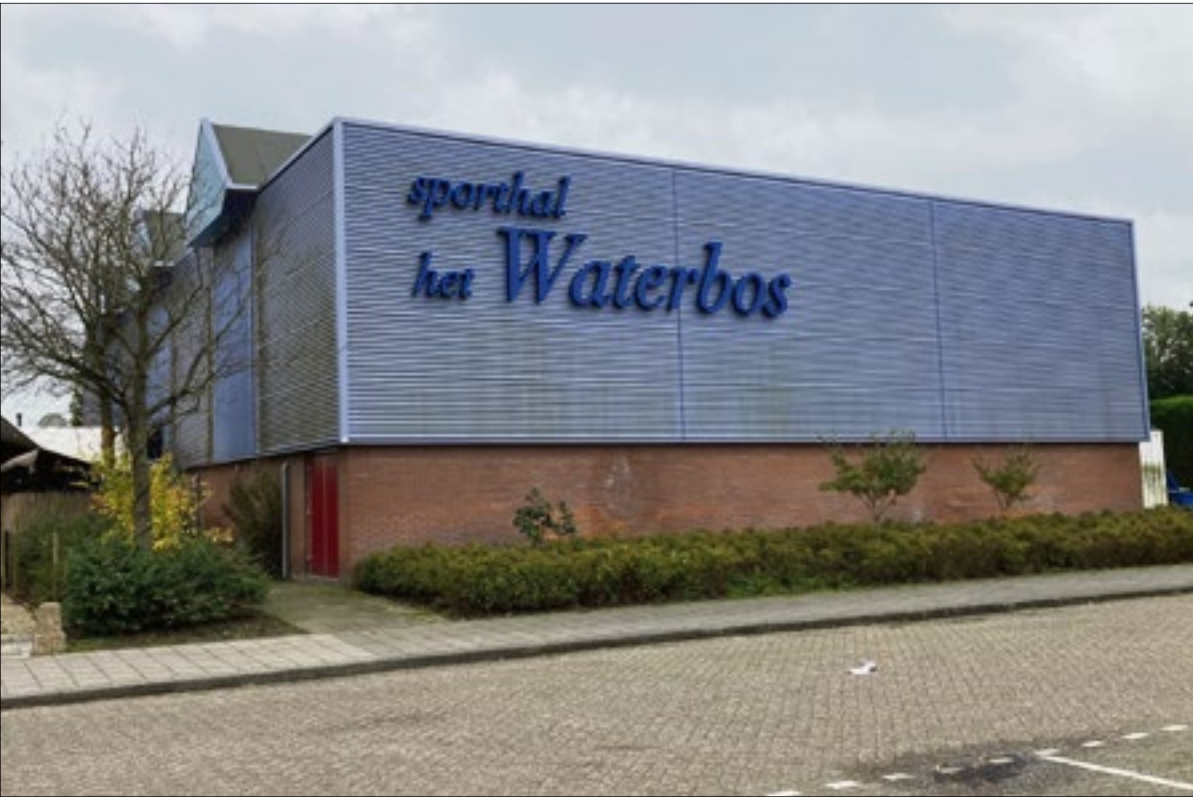
Sportzaal Het Waterbos wordt gerenoveerd en duurzamer gemaakt. | Foto: CvdS
